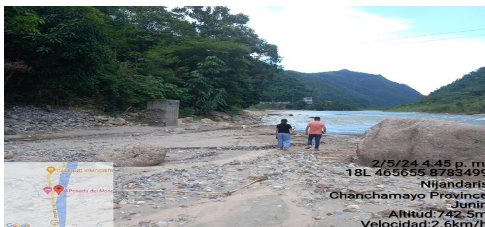
FIGURA N°03: : Material colmatado en el rio Chanchamayo margen izquierda donde se propone la proteccion con enrocado.
