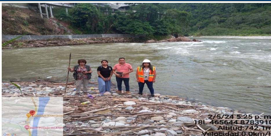
FIGURA N°01: : Cauce del rio en epocas de estiaje, tramo donde se propone defensa ribereña; Material a descolmatar en cauce de rio.
